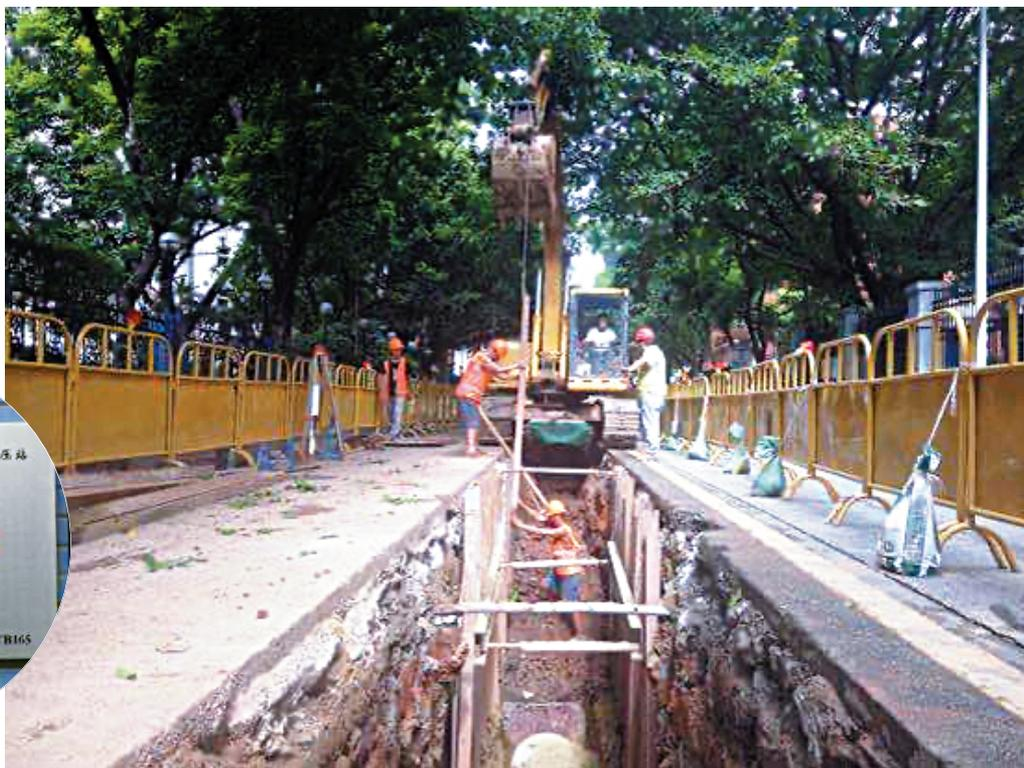
■在清污分流、排水单元达标建设施工中,工人正在做挡土板槽钢支护。 通讯员供图
