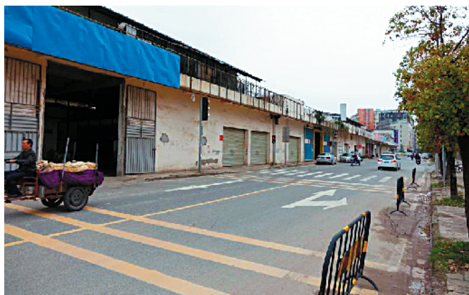
■番禺区大石街河村村工业园改造前的旧厂房。受访者供图
