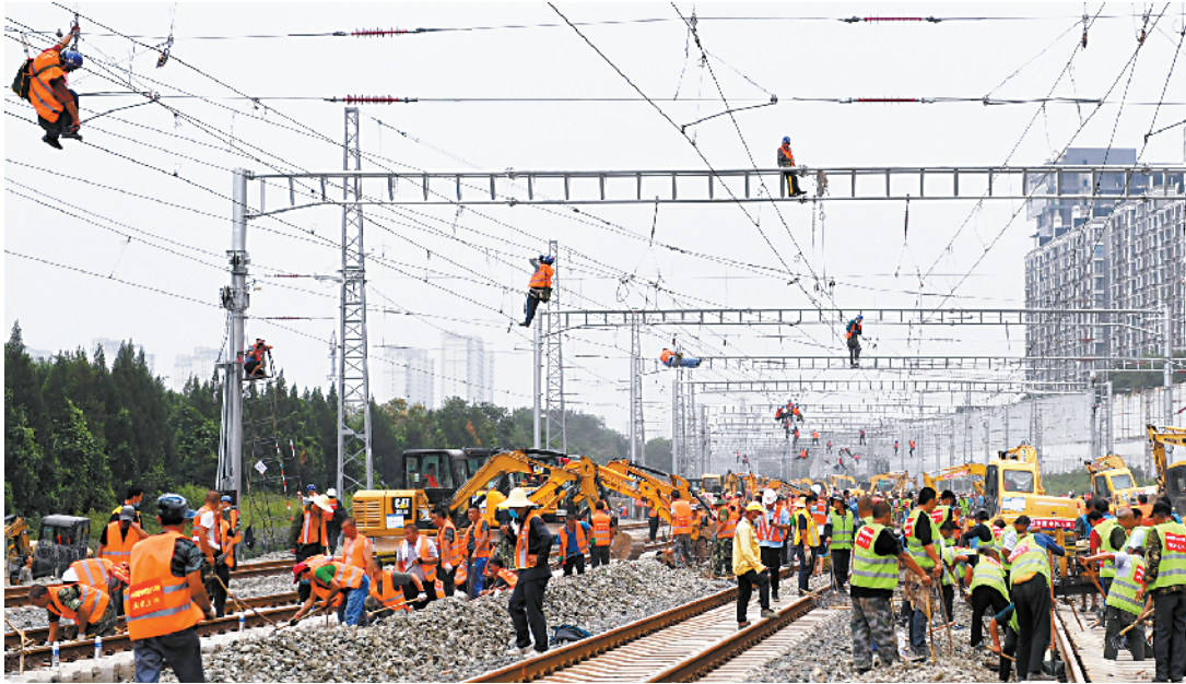
■ 8月30日,中铁六局的施工人员进行拨线作业。 新华社发
