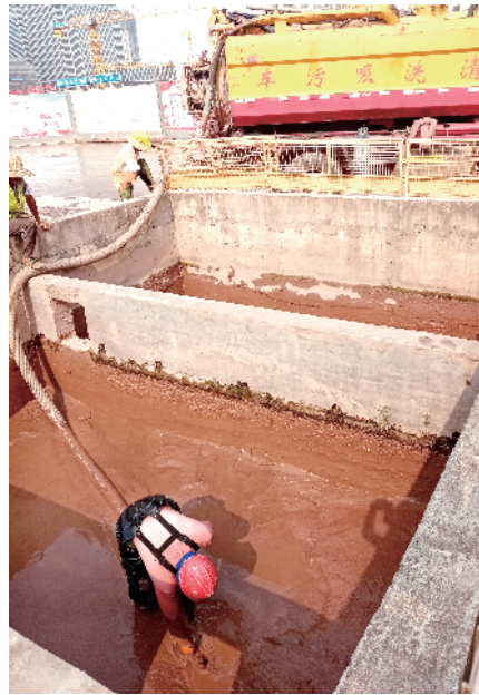
■工人正在用清洗吸污车吸走黄泥。
