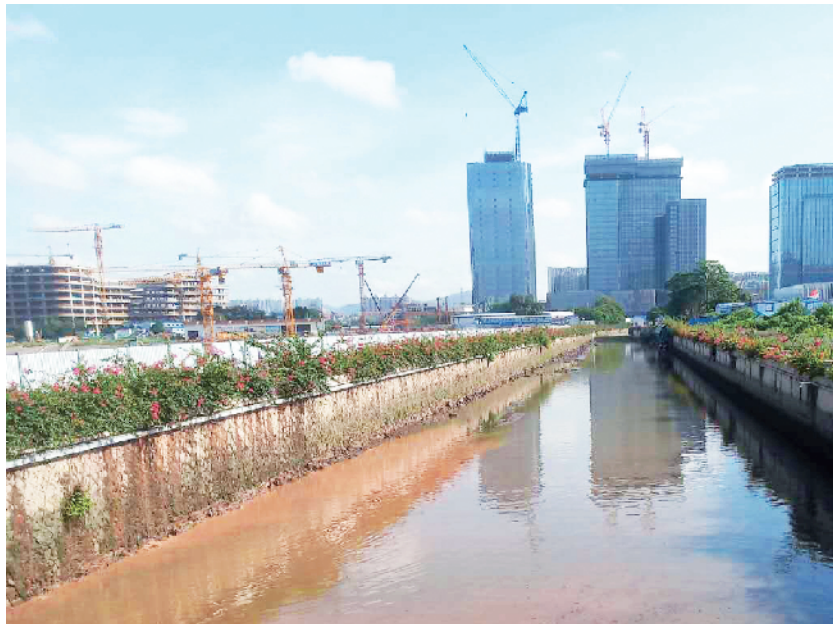
■位于广州天河的金融城工地黄泥水流入棠下涌。受访者供图
