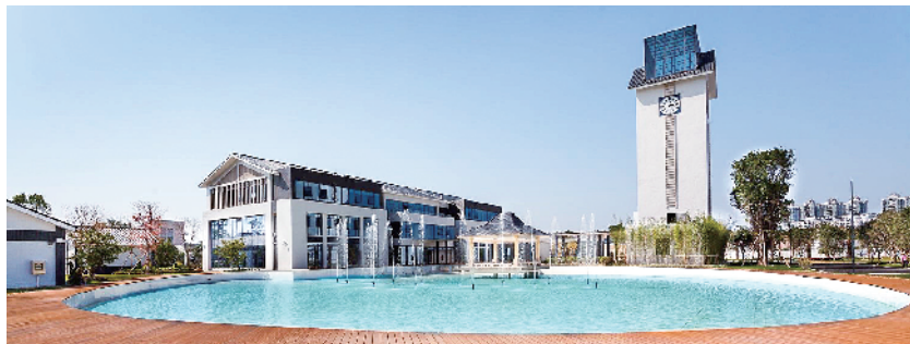
■广州市一家地埋式净水厂的厂区如同景区,看不出地下在处理数以万吨计的污水。
