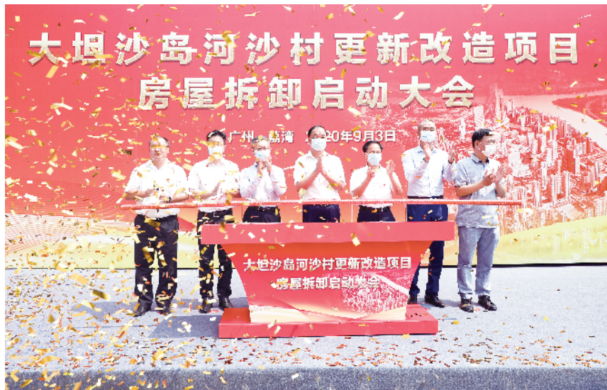
■荔湾区大坦沙岛河沙村于 9 月 3 日启动房屋拆卸工作,首批 23 栋厂房、村屋有序拆除。
