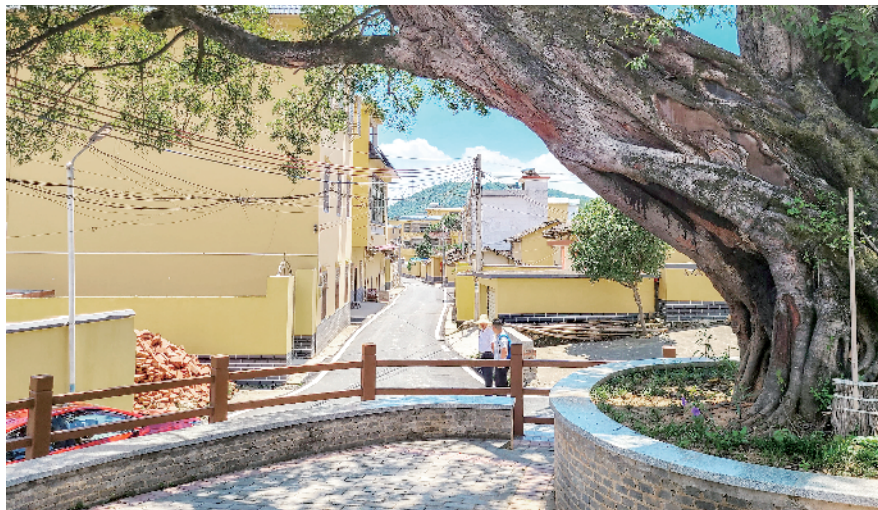
■南雄市珠玑镇中站村精品街项目已经接近尾声,村里环境大为改善,旅游产业发展再添新亮点。
