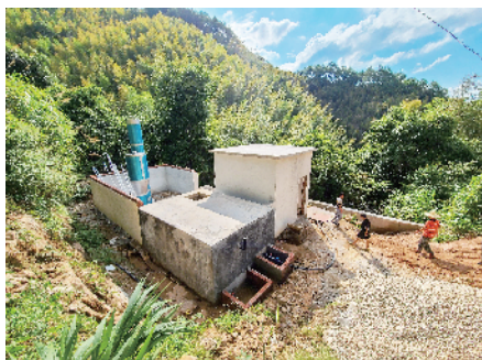
■南雄市江头镇鱼仙村上东坑的水源供水处正在建设中,蓄水池、过滤器都已建成装好,管道也铺设好了。
