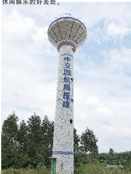
■中交四航局帮扶公和村建设的供水塔。
