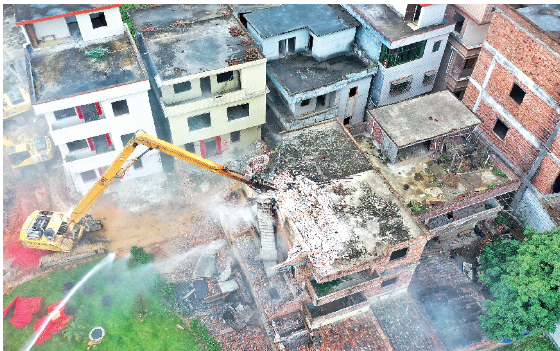
■2020年4月22日,广州黄埔区、广州开发区中新广州知识城片区启动九龙大道、广汕路沿线旧村改造集中连片拆除行动。新快报记者 李小萌/摄(资料图片)
