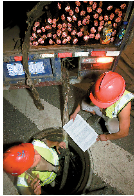
◀2020年8月24日,通信铜缆在广州市内自动电话的发源地人民中路一带退出服务,施工人员从地下管井中抽出的退役通信主干铜缆。
