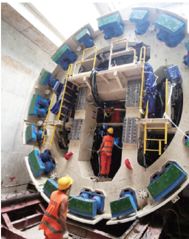
■广州地铁十号线盾构机组装。
