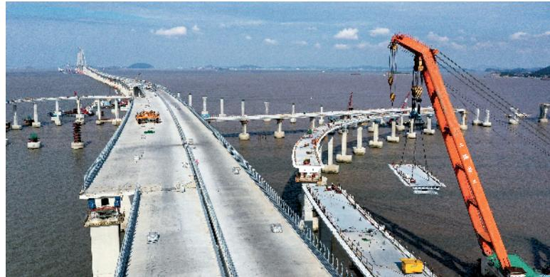
10月28日,在舟岱大桥海上互通(长白互通)D匝道施工区,大型机械在吊装钢箱梁。当日下午,该施工区的最后一片钢箱梁顺利吊装完成。舟岱大桥海上互通包含五条匝道,共需钢箱梁65片,截至目前已架设32片,预计今年底全部架设完成。 新华社发
