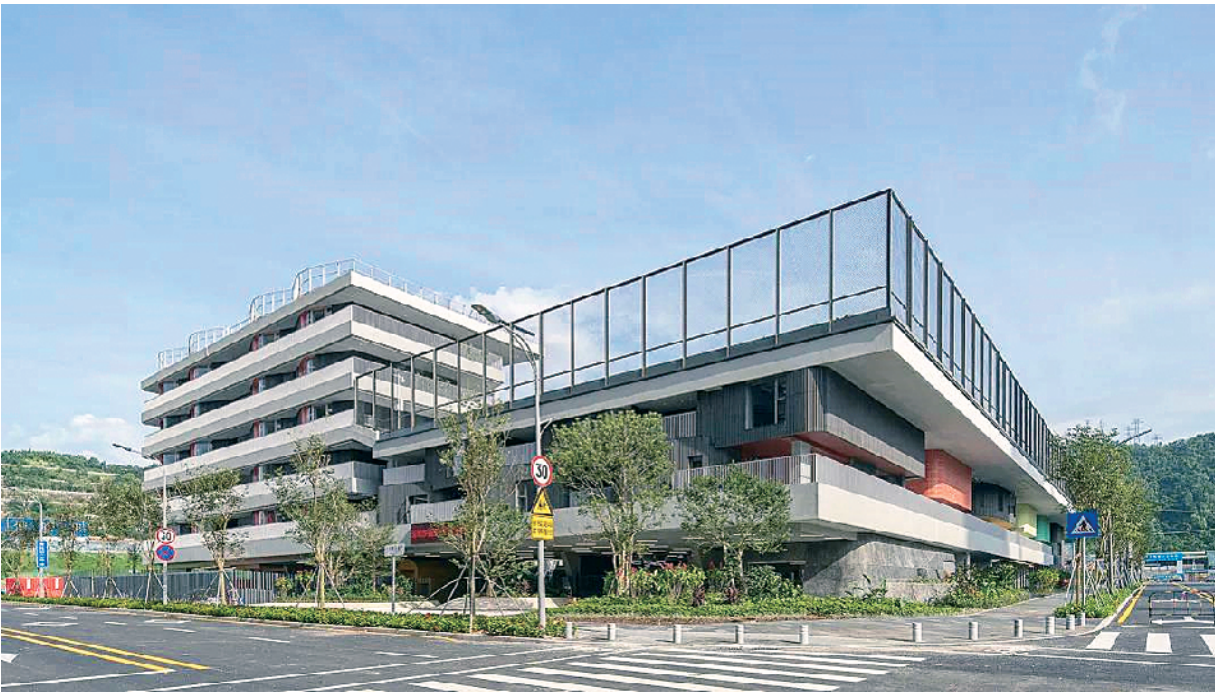
■深圳的红岭小学将田径场抬升到 3-5 层,再把体育馆、游泳馆、图书馆、剧场等大空间设施或开敞空间设置在田径场的屋盖下。
