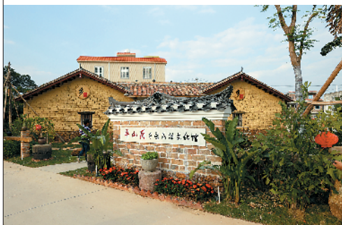
廉江高桥镇平山岗村将老房子改造成平山岗乡愁民俗文化馆。
