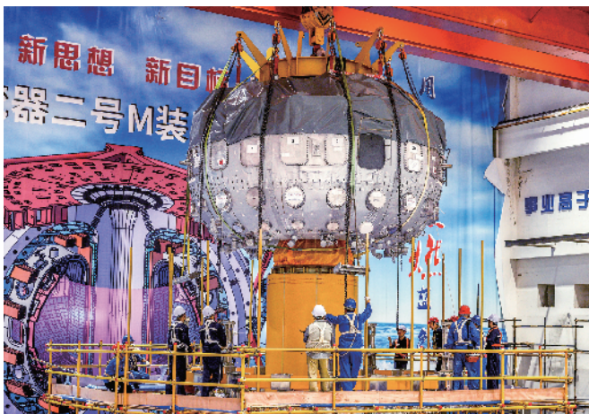
■中核集团核工业西南物理研究院的工作人员在安装调试中国环流器二号M装置。新华社发
