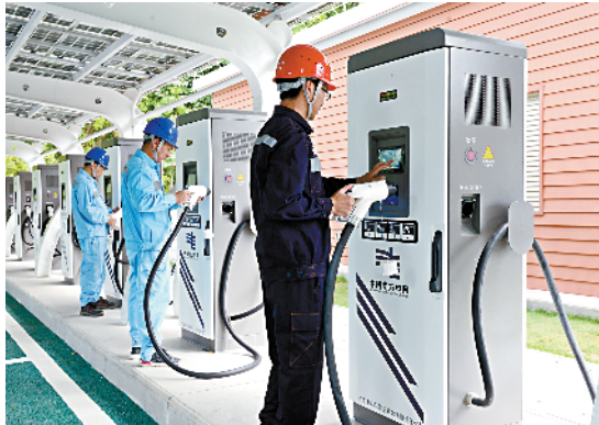
■南方电网广东东莞供电局供电人员为松山湖太鲁阁光储充项目进行调试。(顾萱 摄)
