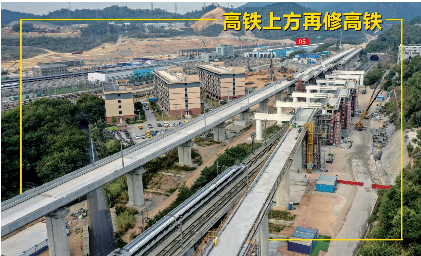
■赣深铁路福龙路特大桥上跨广深港高铁箱梁横移施工启动，广深港高铁为珠三角地区繁忙的铁路干线，平均3分钟就有一辆动车通行，施工难度巨大。
