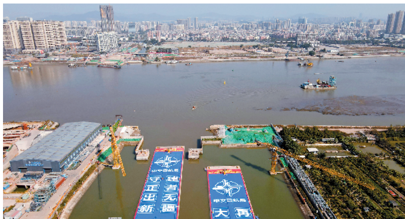
■6万吨的“巨无霸”沉管(E3沉管)于1月18日浮运出坞。新快报记者 毕志毅/摄
