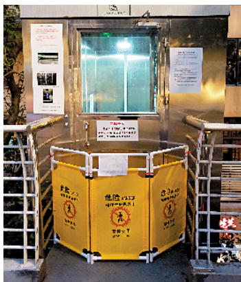
■1月20日傍晚,这两处天桥的无障碍电梯已被围蔽起来,正在进行自动化升级改造,改造期间设备暂停使用。
