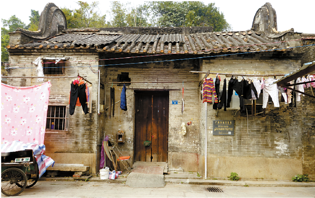
■历史建筑、村内仅存完整祠堂李氏宗祠外墙、灰塑已风化残损，正面墙上一个大洞赫然在目，头门前檐墙严重开裂并倾斜变形。
