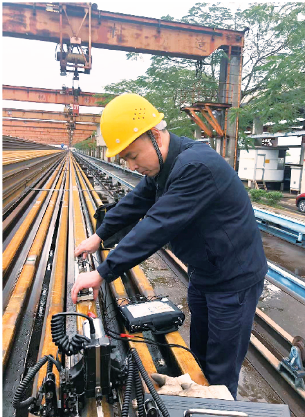
■吴向进在对钢轨进行“诊断”。通讯员供图
