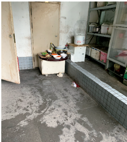
■小区6楼公共平台成了工作人员生活区。
