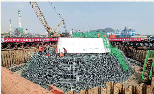
■建设中的滨海湾大桥
