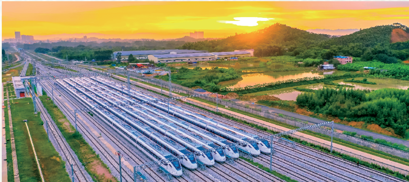
■2020年11月30日,广清城际(花都站至清城站)、广州东环城际(花都站至白云机场北站)正式开通运营,标志着广州地铁首次接管运营城际线路。
