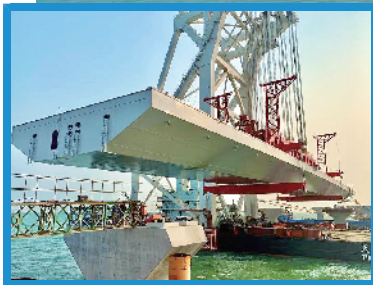
■深中通道首片钢箱梁于4月2日下午顺利完成架设。通讯员供图
