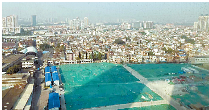
■海珠区沥滘村旧村改造配图。新快报记者 毕志毅/摄
