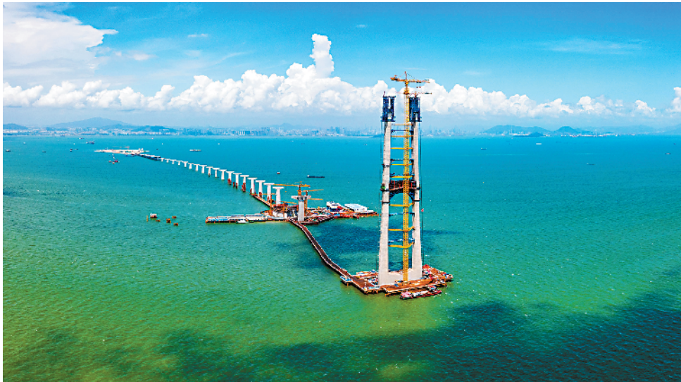
■6 月 17 日,随着第 48 节塔柱混凝土浇筑完成,由中交二航局承建的深中通道伶仃洋大桥东索塔完成封顶。新华社发
