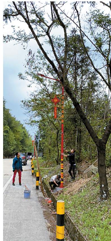
■工作人员正在安装这种带有自动调光功能的路灯。
