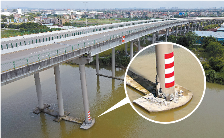
■北斗大桥一桥墩被撞,桥墩出现了明显的倾斜。
