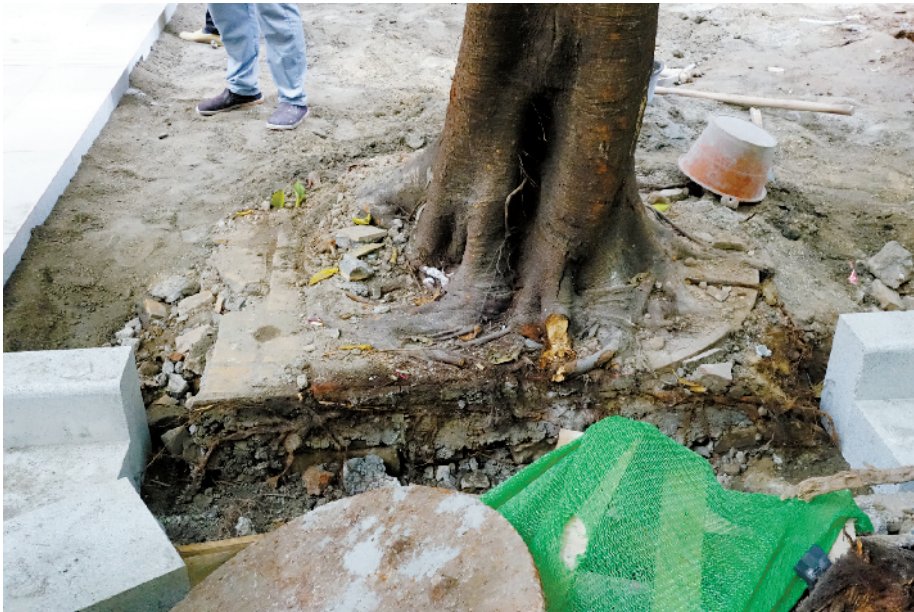
■这棵树在人行道施工时被断根,后来在一场暴雨中倒下。
