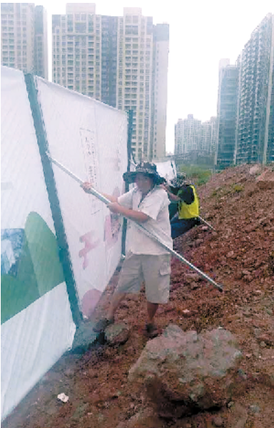
■ 台风间隙加固围挡
