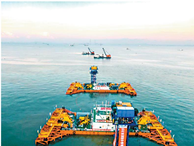
**新快报讯** 记者许力夫 通讯员粤交集宣 岳路建报道 8月30日13时,历经38小时连续施工作业,粤港澳大湾区超级工程——深中通道沉管隧道东端首个管节E32完成沉放安装。
