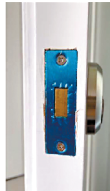
▲五金配件与原设计版本不符,安装时造成门部损坏。
