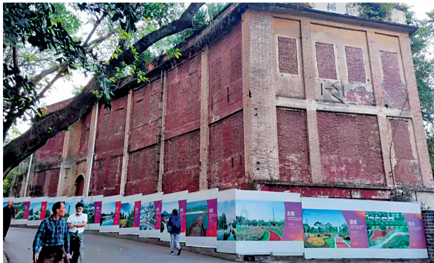
■骑压在明城墙上的民国建筑险遭拆除，现将修缮。
