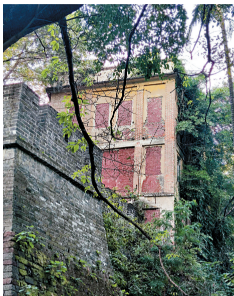
■民国建筑北部直接立于古城墙遗址墙基之上。
