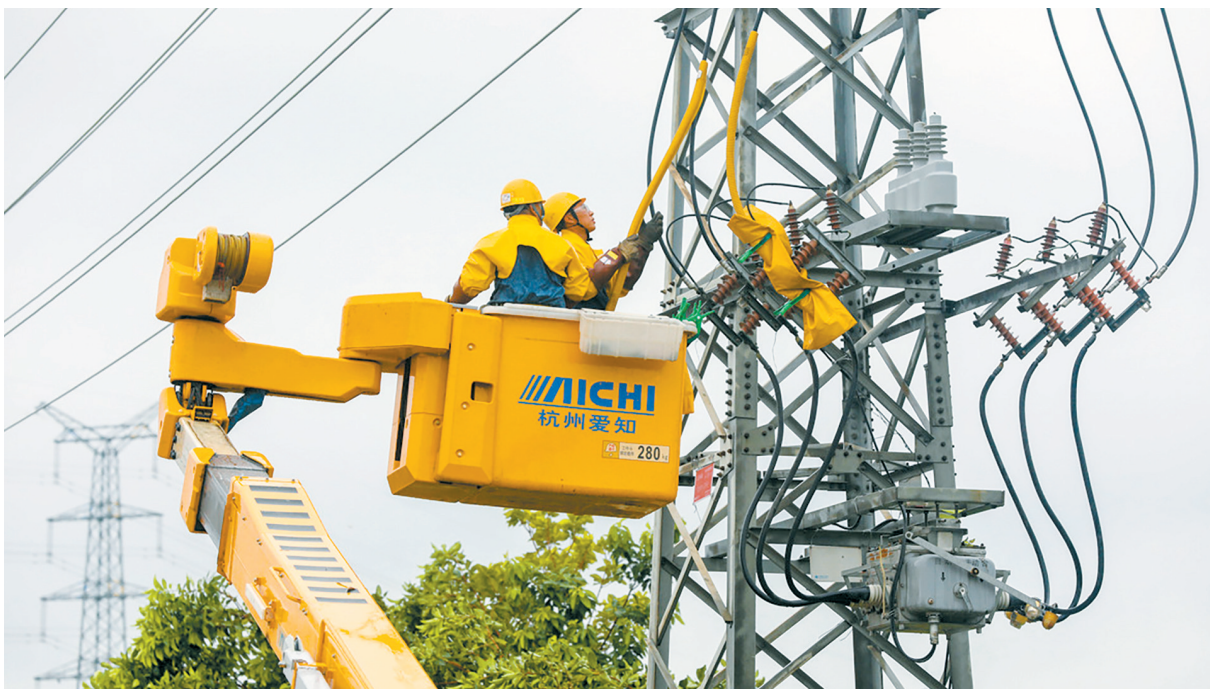
■中山供电局应急抢修党员突击队开展带电作业工作。
