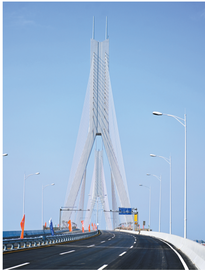
■鹤洞大桥大中修工程桥面部分主体工程顺利完工。
