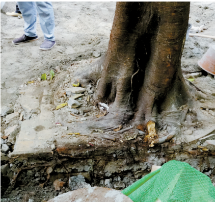
■在人行道铺装施工时,施工人员切断树根,拓宽马路侵占树木生长空间。
