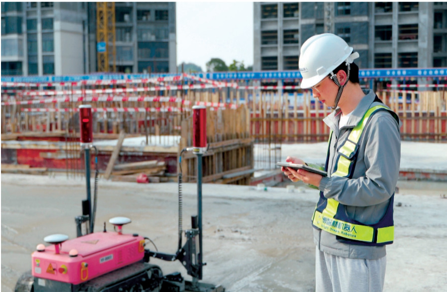
■博智林智能建造产业技师在操控地面抹平机器人。
