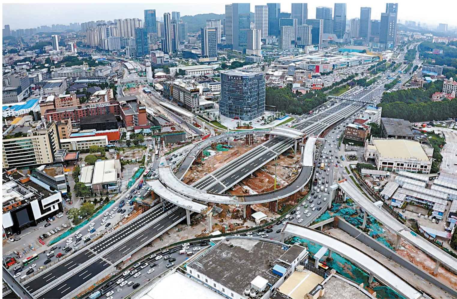
■历时16个月的南大干线工程番禺大道主线跨线桥已完成验收,定于今日9时开放,届时将有效缓解该路段交通压力。
