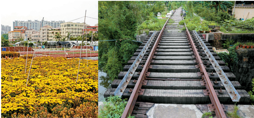
■广钢铁路过村庄、跨河涌,沿线的村庄是著名的花卉种植地,是一条观光线。
