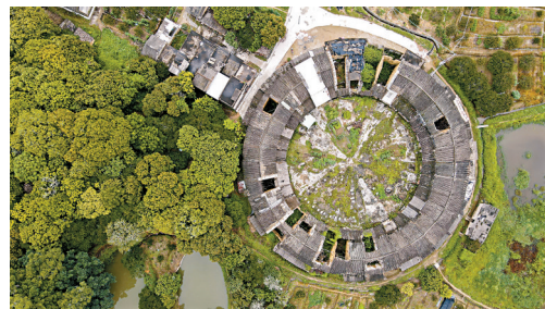
■东山镇西山村还保留着全镇占地面积最大、保存相对完整的围楼。
