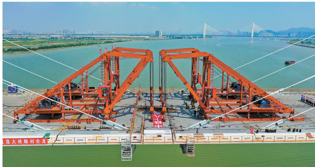
新快报讯 记者朱清海 龚吉林报道 大江飞长虹,湾区添通途。7月25日,随着最后一节重达113吨的钢箱梁精准吊装到位,全长1772米的广州市跨度最大市政斜拉桥红莲大桥主桥正式合龙。接下来,大桥将开始进行路面及附属设施施工,按计划于2022年12月底通车。
