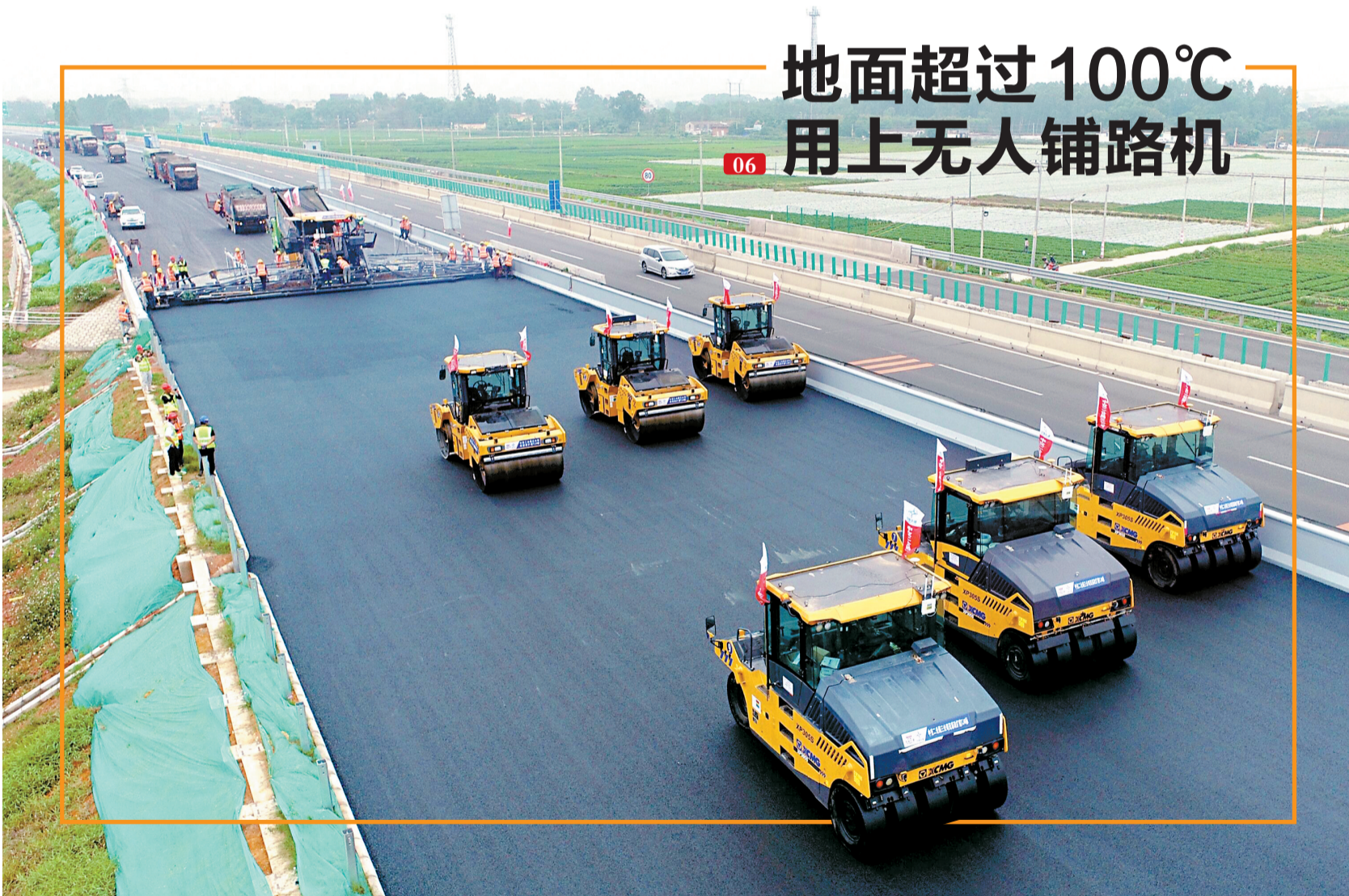
■昨日，茂湛高速改扩建路面施工现场，在温度超过100℃的路面，无人驾驶摊铺机、压路机正有序施工，这是在广东高速沥青中面层施工中首次引进了无人驾驶碾压机群。
