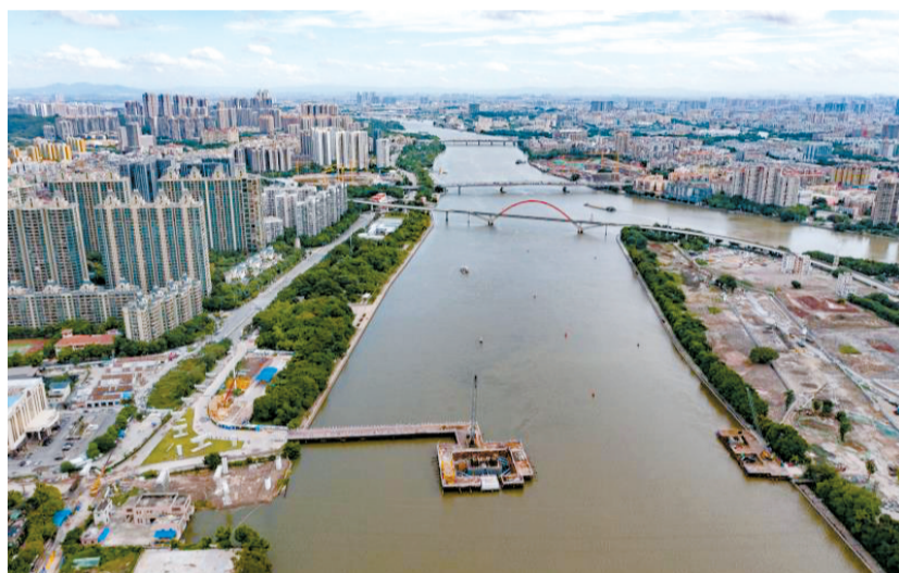
■建设中的广佛大桥。通讯员供图
