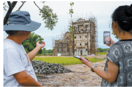
■张小明带领团队将双龙自然村的一座碉楼修复改造成博物馆。
