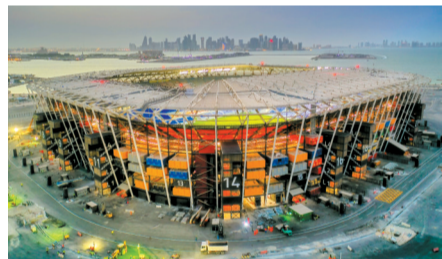
■“974球场”是一座建立在人工岛上的体育场,主要建筑材料为974个集装箱。另外,974也是卡塔尔的长途电话国际区号。
