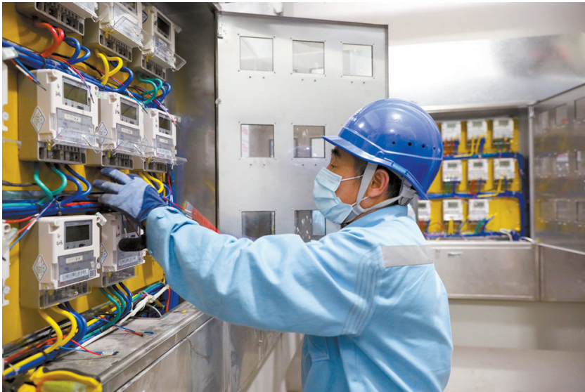
■ 南方电网广东中山西区供电分局计量运维人员为居民小区安装电表。
