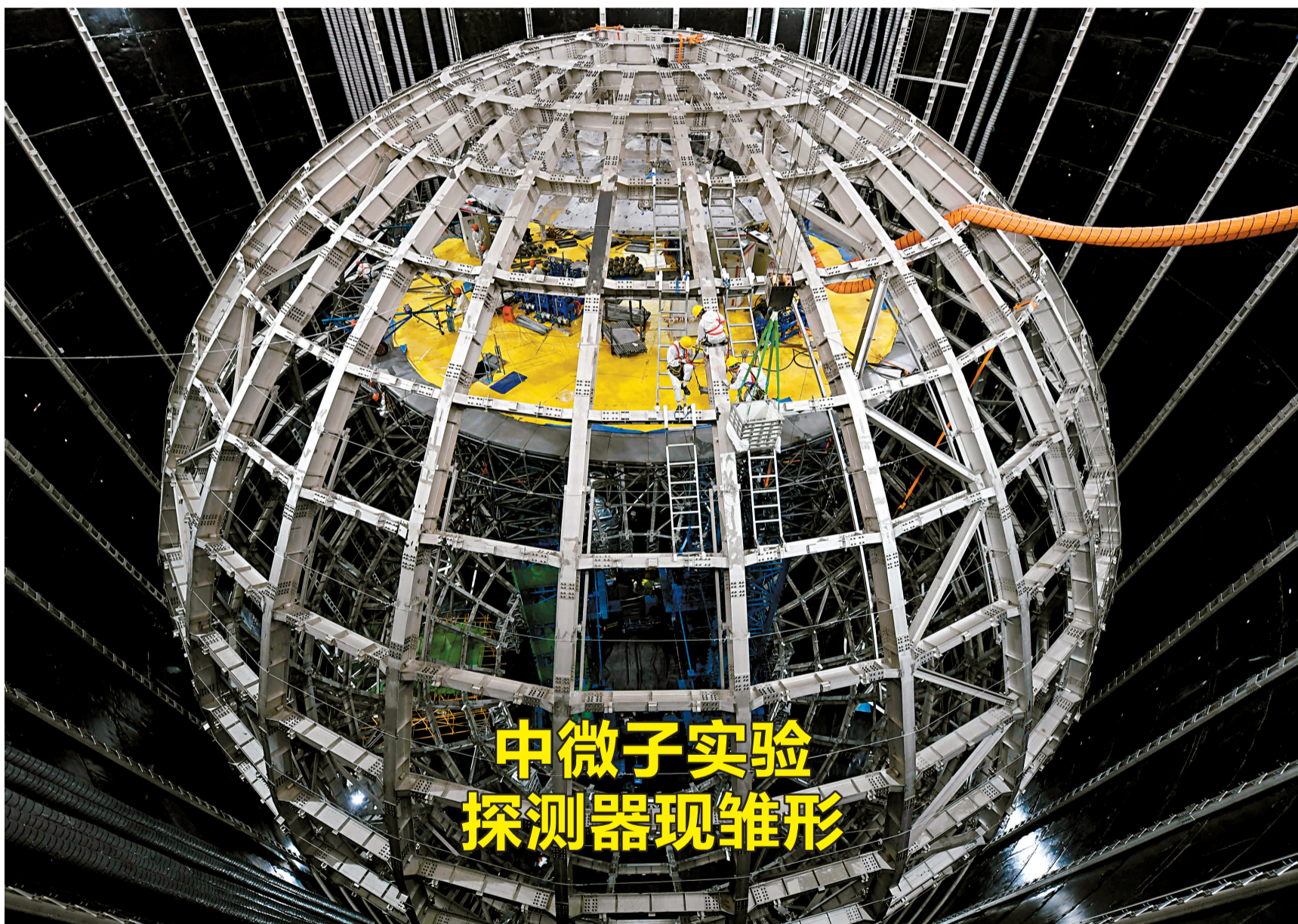
■9月2日,施工人员正在位于地下700米的江门中微子实验探测器上作业。江门中微子实验位于广东省江门开平市,是由中科院和广东省共同建设的大科学装置,以测定中微子质量顺序、精确测量中微子混合参数为主要科学目标,并进行其他多项科学前沿研究。项目预计2024年建成运行,届时将成为国际中微子研究的中心之一。新华社发
