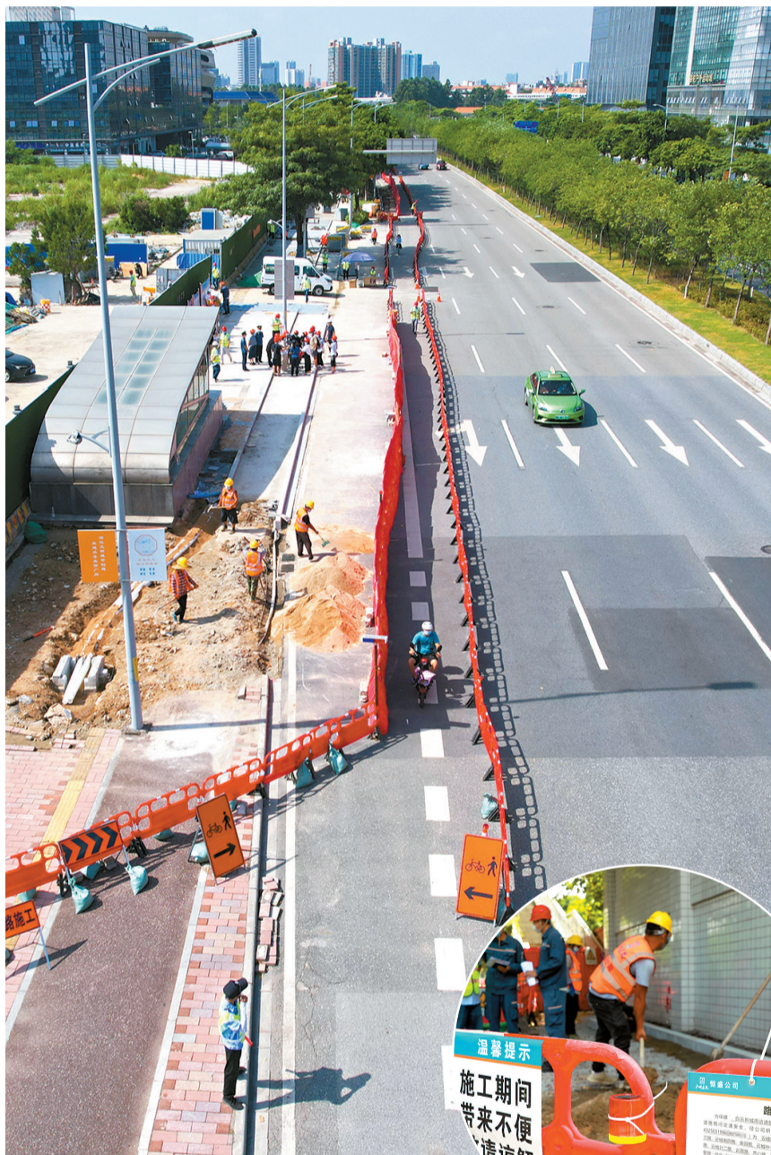
■白云新城一道路升级改造项目施工现场。
