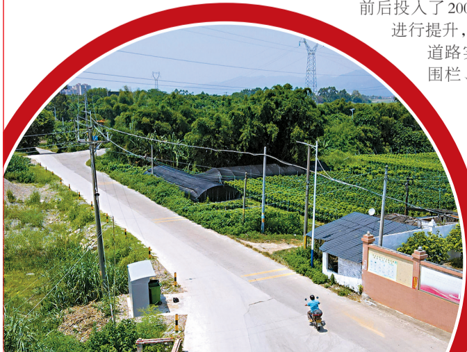
■安平村村道旁装上了路灯。
